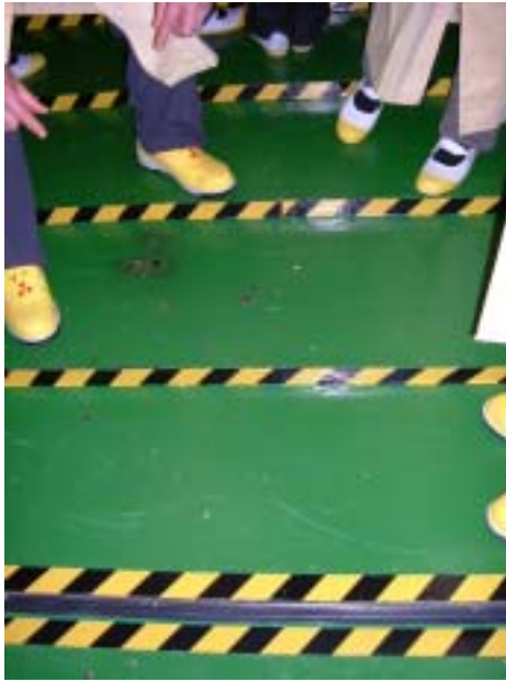
TRACY の出入口 入り口側からは段差がわかるが、出るときにはわからない
