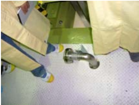
STACY 作業エリアの突起物 何も表示がない
