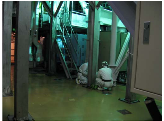
JT-60本体室内での作業の様子
