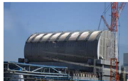
3号機建屋 建屋上部に設置された 燃料取り出し用ドーム状カバー 東京電力より提供
