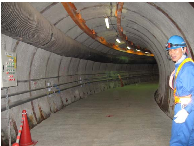
幌延深地層研究センターの坑道（地下350mにある）
