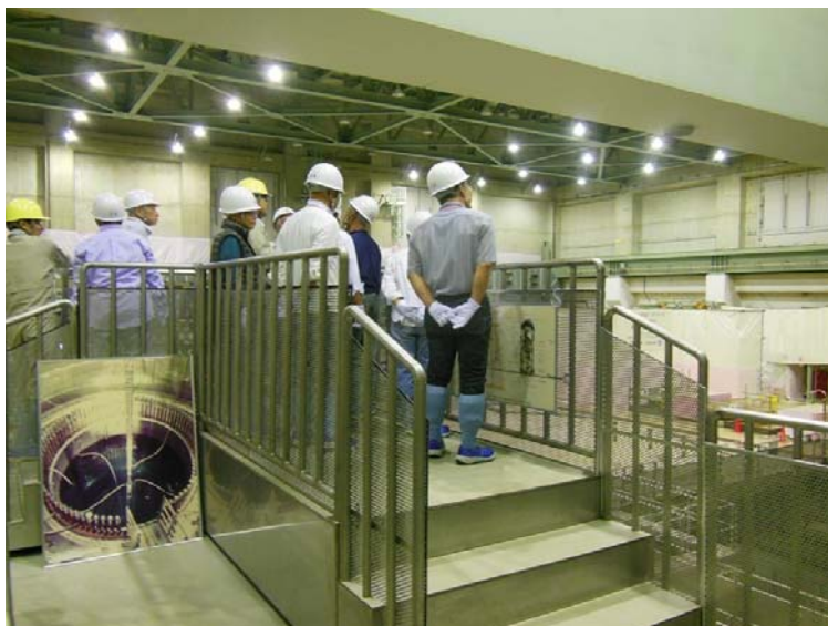
原子炉建屋内にて（眼下に原子炉と燃料プールがある）
